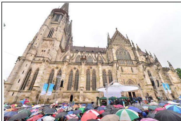
Nasskaltes Wetter trübte die Eröffnung. Foto: Staudinger
